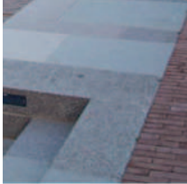
Отделка ступеней гранитными плитами
